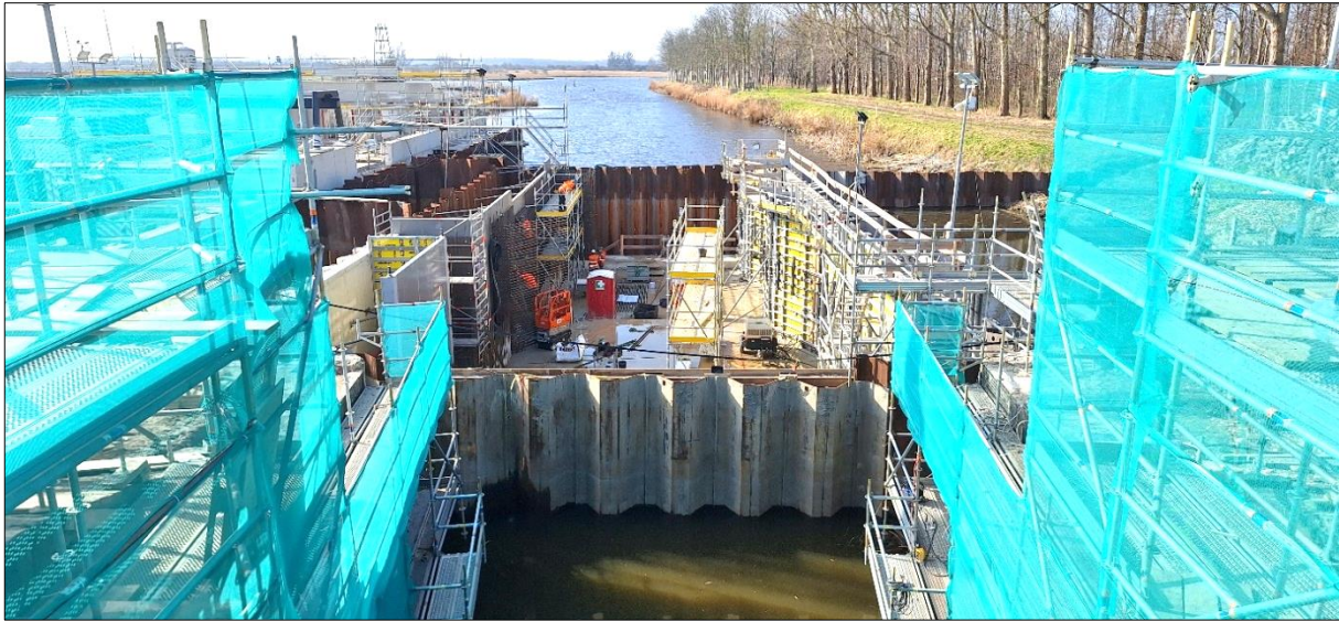
Op deze en vorige pagina: Afbeelding van het gemaalgebouw, de nieuwe kelders in de Hunsingsluis en zicht op de nieuwe sluis.
